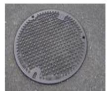
旧型マンホール蓋（浮上防止、耐スリップ性能無し） 新型マンホール蓋（浮上防止、耐スリップ性能有り）
